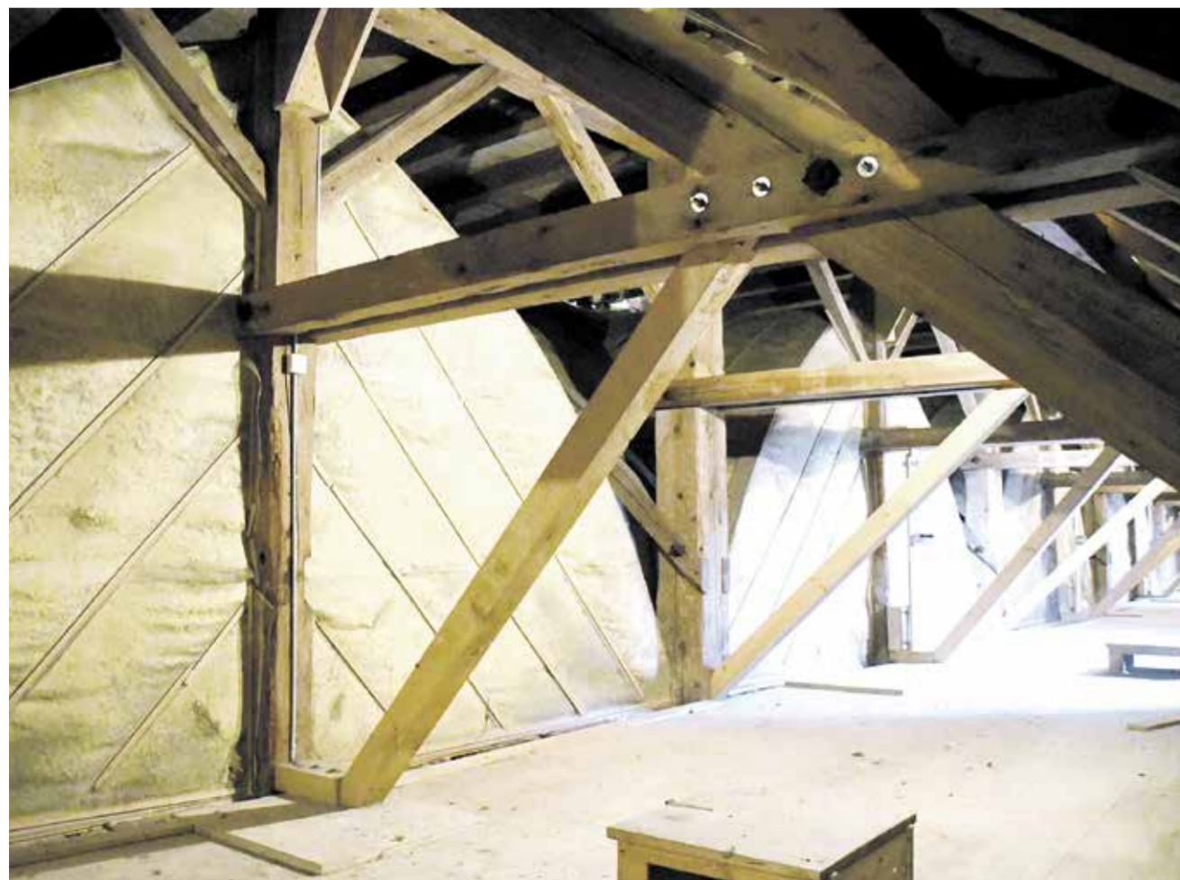
Blick auf die Rückseite der Kreuzrippengewölbe, die die Staffelhalle des Mittelschiffs so wunderbar wirken lassen, in denen aber mehr Holz steckt als man auf den ersten Blick annimmt.
