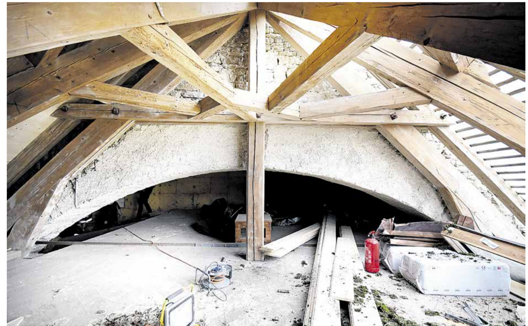
Wer unter dem Dach über dem Chor steht und in Richtung Kirchturm blickt, entdeckt Mauerwerk, das aus der Bauzeit der Kirche (1851–53) stammt.
