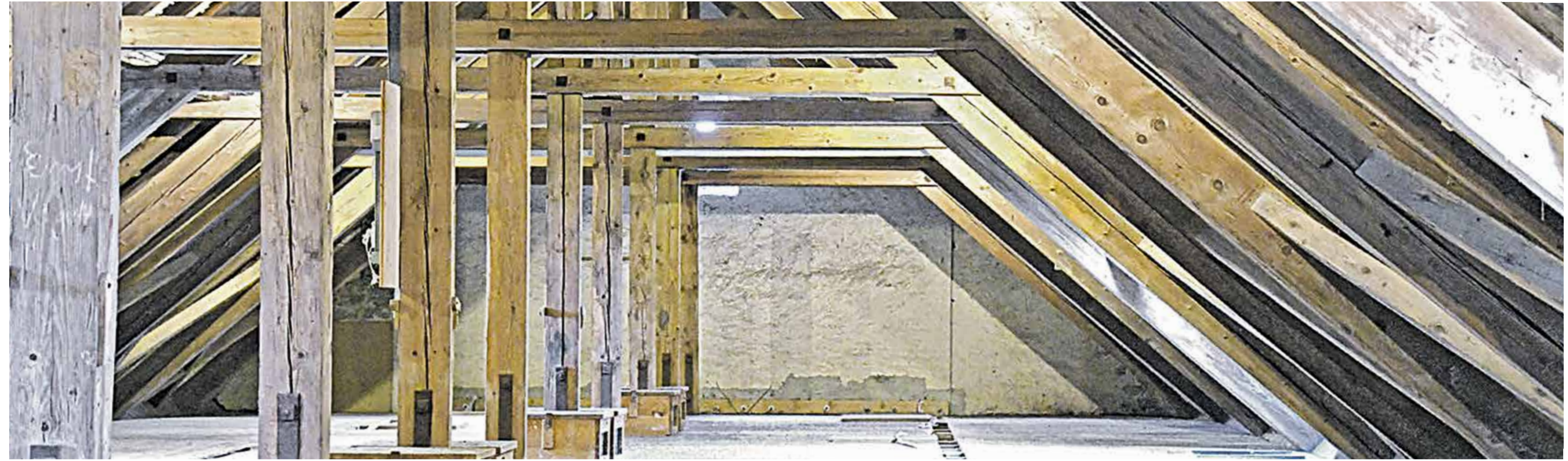
Der Dachstuhl über dem Mittelschiff ist sehr gross und ungenutzt. Ins Auge stechen die Giebelsäulen, die die Firstpfette tragen.
