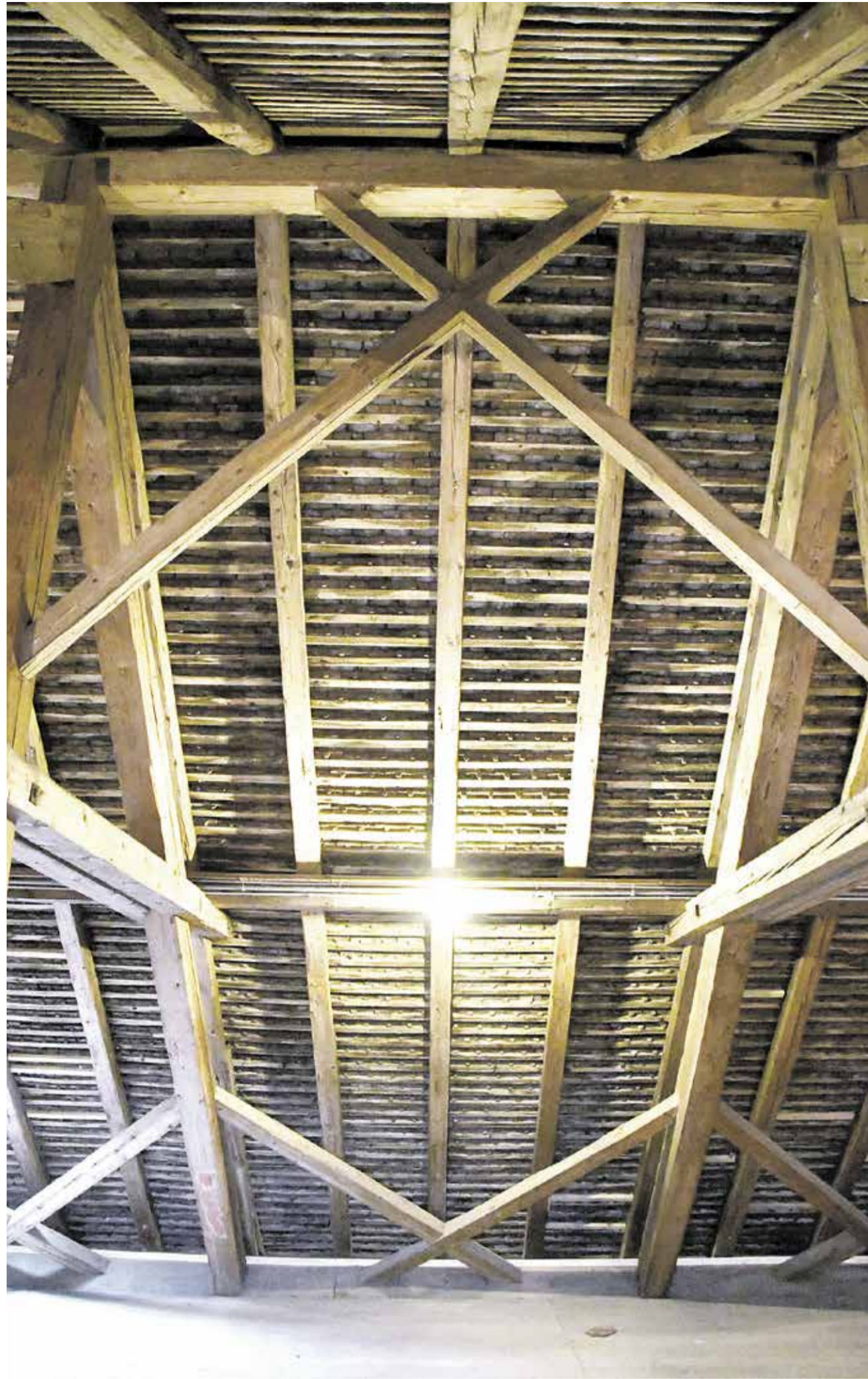
Symmetrien im Dachstuhl des Mittelschiffs. Gut zu sehen ist die querlaufende Holzlattung, auf der die vielen tausend Dachziegel der Kirche liegen.
