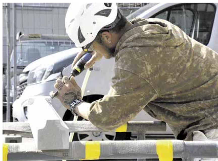
Steinmetz Torsten Isecke bearbeitet einen der Sockel, der neu in eines der Mittelgewände der Kirchenfenster eingesetzt werden soll.
