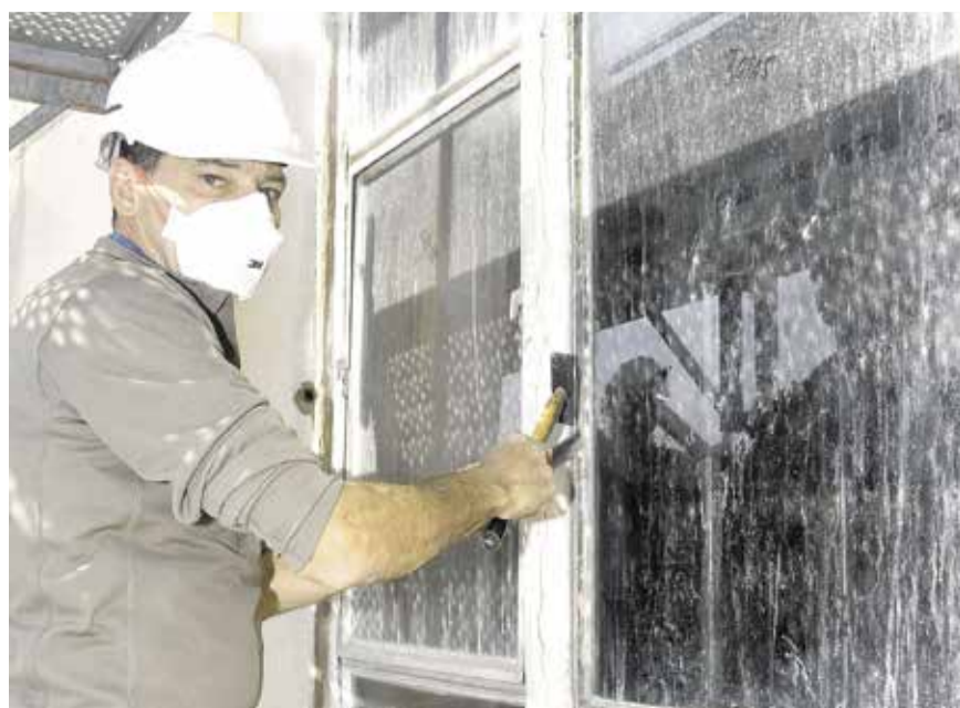
Dieter Scholz, der Vater von Patrick Scholz, löst den brüchigen Leinöl-Kitt aus dem Metallgerüst der Leuggerner Kirchenfenster.
