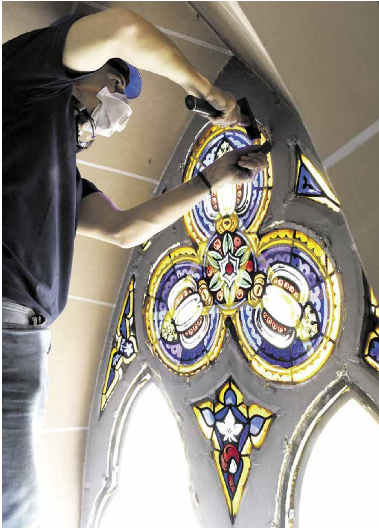
Mit feinem Aushauwerkzeug löst Patrick Scholz eine Rosette mit drei Pässen aus einem der Fenster im Schiff der Kirche Leuggern.
