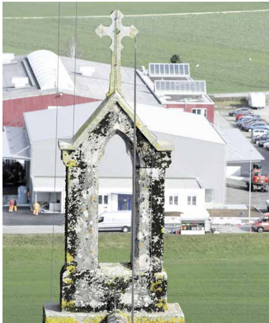
Auch der Dachreiter auf dem Kirchendach wird gereinigt und instandgestellt.
