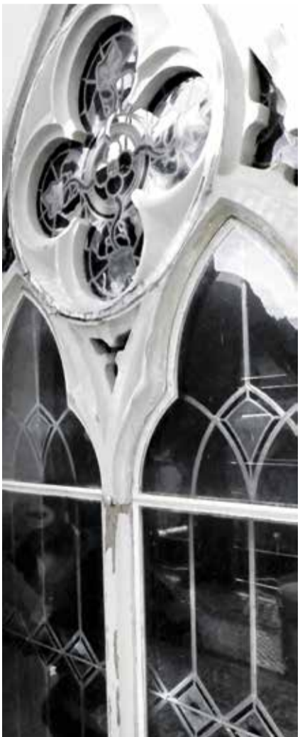
Die Instandstellung der Fenster im Schiff und erfordert viel Fachwissen.
