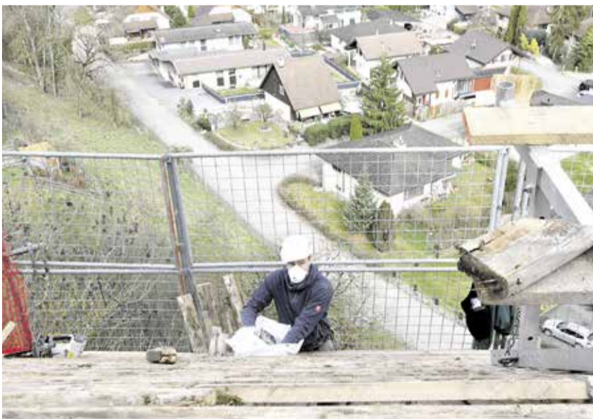
Bereits werden erste Arbeiten am Dach des Chors ausgeführt.
