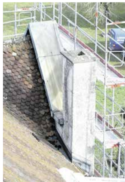
Der 1949 erstellte Kamin für die Ölheizung der Kirche wird im Zuge der Aussensanierung zurückgebaut.
