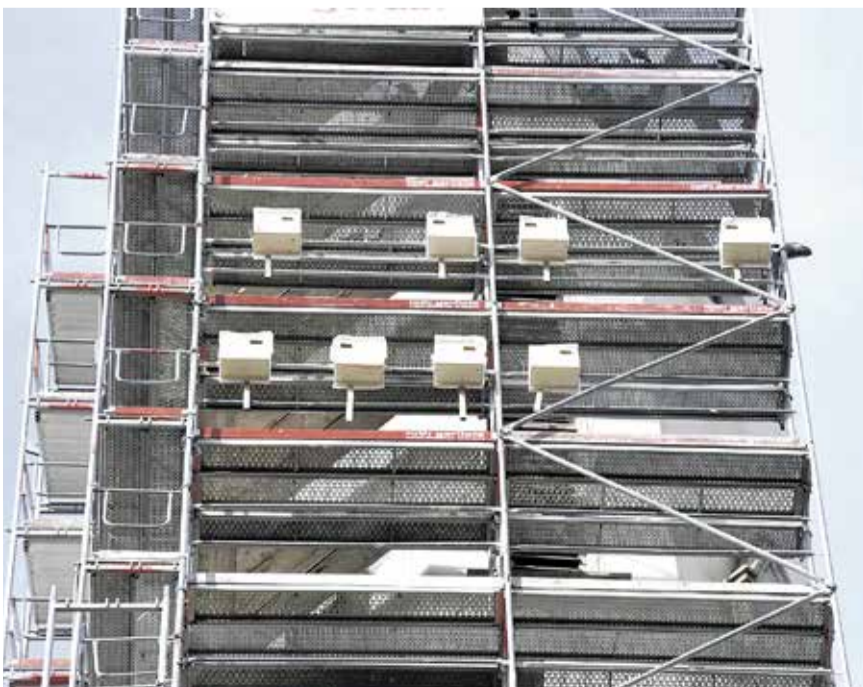
Damit die Dohlen, die sonst im Kirchturm daheim sind, auch während der Bauzeit ein Zuhause haben, wurden am Baugerüst extra Kästen montiert.
