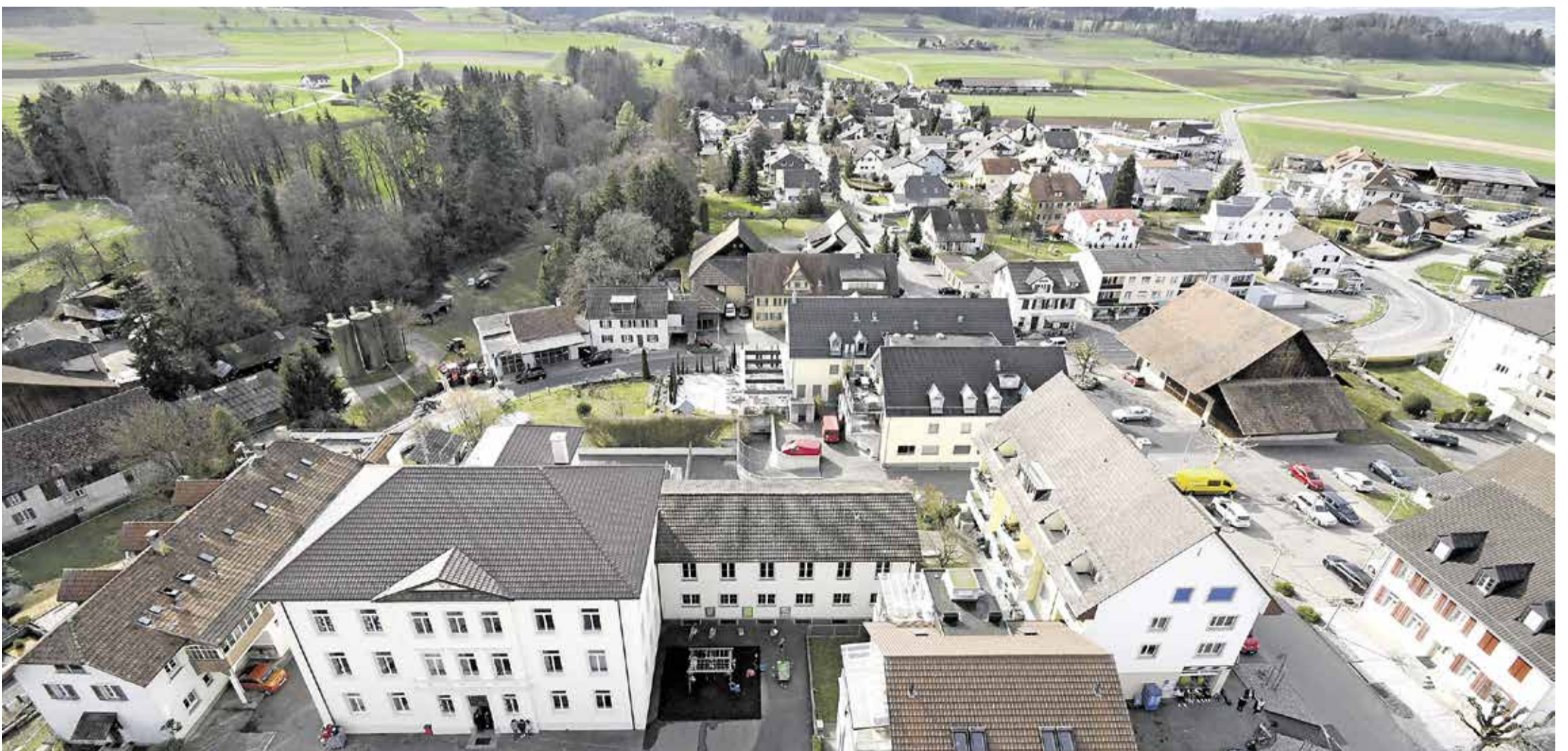
Primarschulhaus und Restaurant Sonne aus ungewöhnlicher Perspektive, dahinter das Leuggermer Grottenquartier, weit im Hintergrund dann die ersten Häuser von Hettenschwil.
