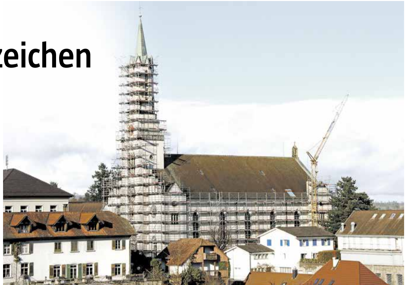
Sie ist ein Wahrzeichen von überregionaler Bedeutung: Seit Februar steht die Leuggermer Pfarrkirche im Gerüst.
